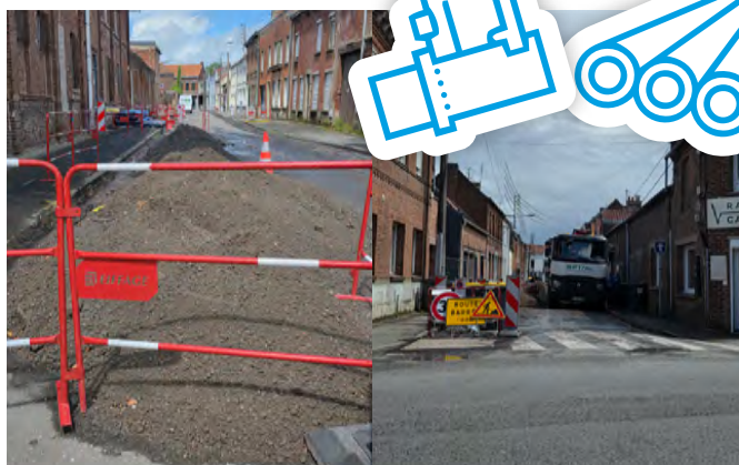
Les travaux ont débuté en mai par la rue Jean-Pierre Viseux
